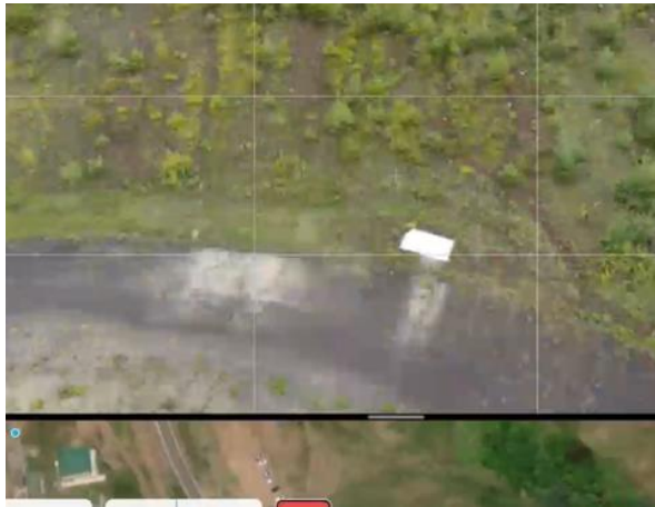
NTT東日本群馬支店による被災通信設備確認映像
